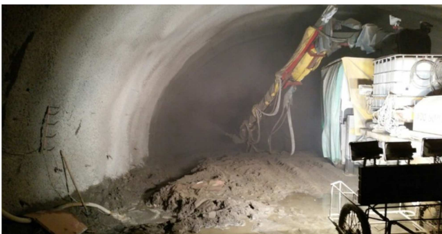
[그림 24] 터널 시공 시 사용되는 샷크리트 머신(Shotcrete machine)
